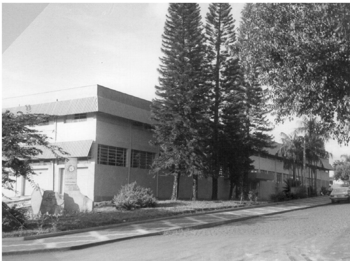
Monumento instalado na esquina do Prédio da Prefeitura
