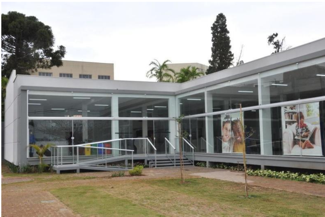
Foto-01: Vista da Fachada
