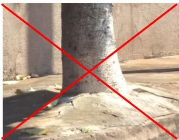
As rachaduras nas calçadas, geralmente ao redor das árvores, ocorrem devido ao fato de estas plantas estarem cimentadas até a base do seu tronco. Desta maneira, não ocorre infiltração de água e nem aeração do solo, sendo que as plantas precisam destes elementos para sobreviver. Portanto, numa medida de sobrevivência, as raízes quebram a calçada em busca destes recursos que lhe faltam.
