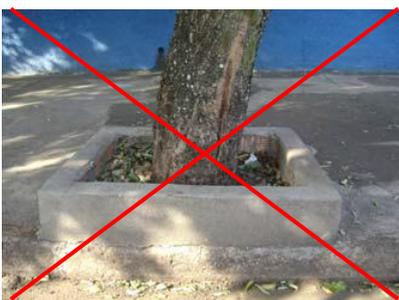
8. Faça o canteiro no mesmo nível da calçada para que as águas das chuvas que escorrem pela calçada possam infiltrar no solo, suprimindo as necessidades da árvore na época das chuvas. A confecção da mureta inviabiliza a infiltração das águas das chuvas para o reabastecimento do lençol freático.
