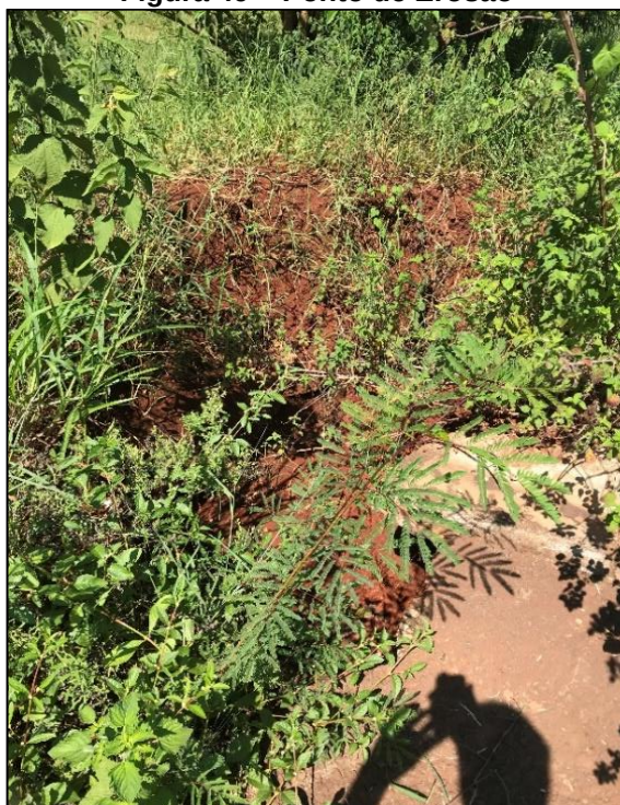
Figura 49 – Ponto de Erosão
