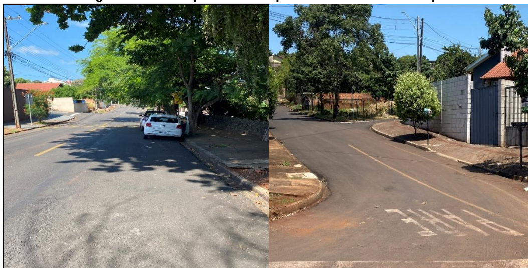
Figura 20 – Exemplos de ruas pavimentadas no município
