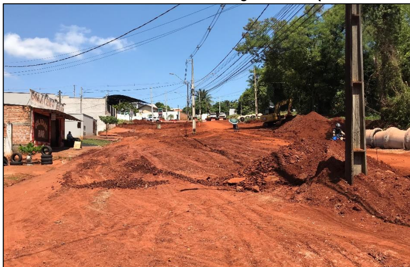
Figura 47 – Obra de Melhorias nas Redes de Drenagem Pluvial (Rua Ibrahim Prud. da Silva).
