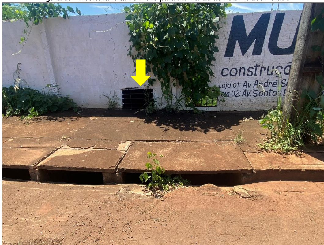
Figura 69 - Abertura feita no muro para dar vazão ao volume acumulado
