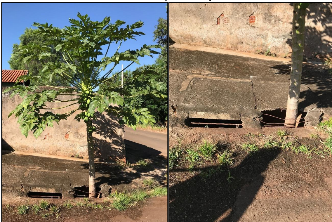
Figura 16 – Registro fotográfico de algumas caixas coletoras com falta de manutenção em Ibiporã.
