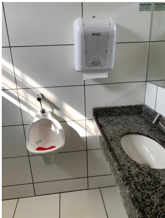
Imagem 29: Banheiro masculino com vista para mictório e lavatório
