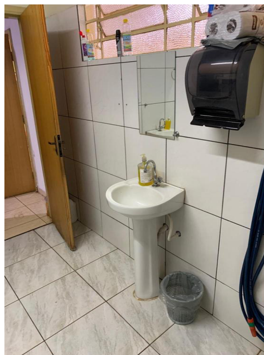
Imagem 40: Lavatório 2 e espelho (banheiro vestiário)
