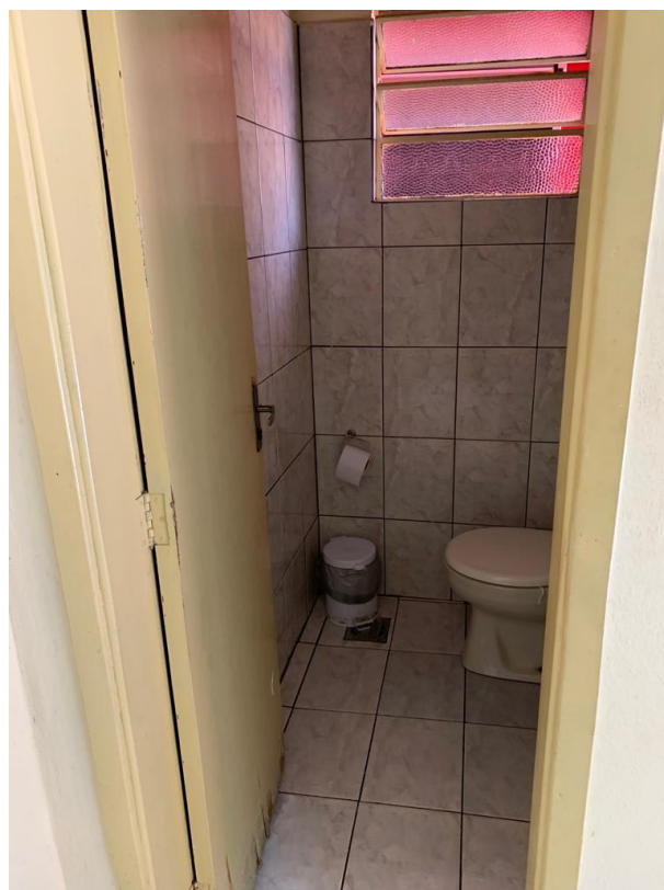
Imagem 126: Porta de acesso ao banheiro da recepção
