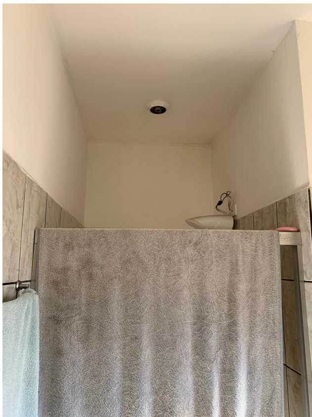
Imagem 69: Box (banheiro dormitórios/sala de descanso)
