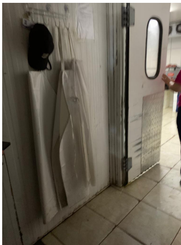
Imagem 76: Porta de acesso à sala de corte/preparo de carnes
