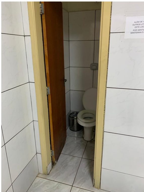
Imagem 41: Bacia sanitária 1 (banheiro vestiário)
