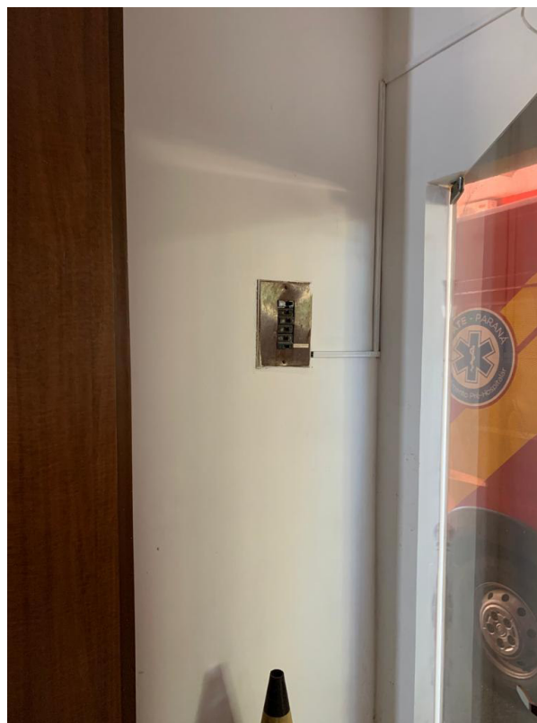
Imagem 144: Quadro de distribuição de energia
