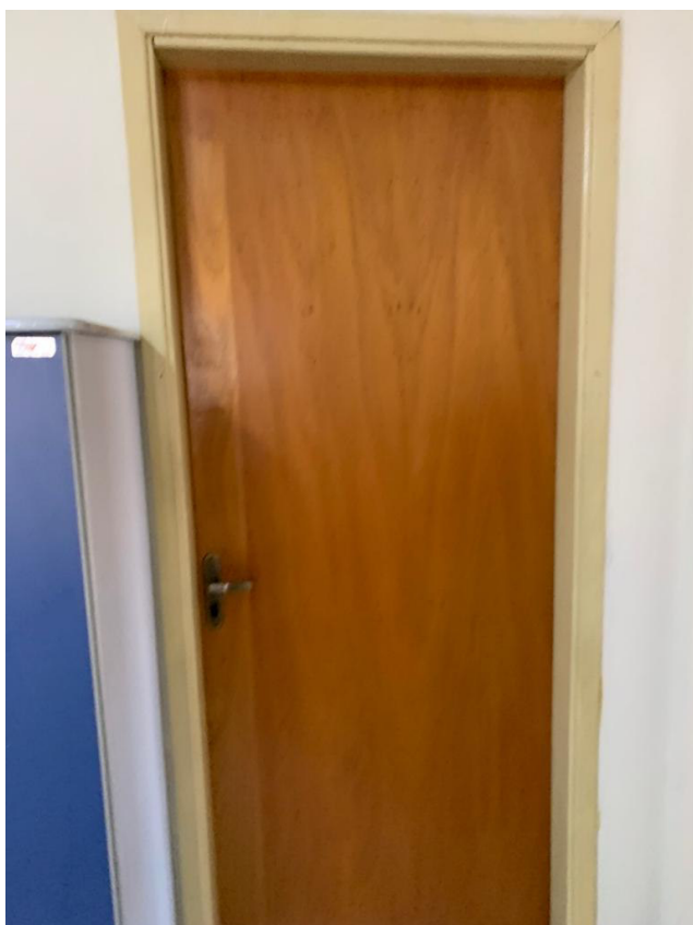
Imagem 139: Porta de acesso à sala de arquivos (Sala 01 Recepção)
