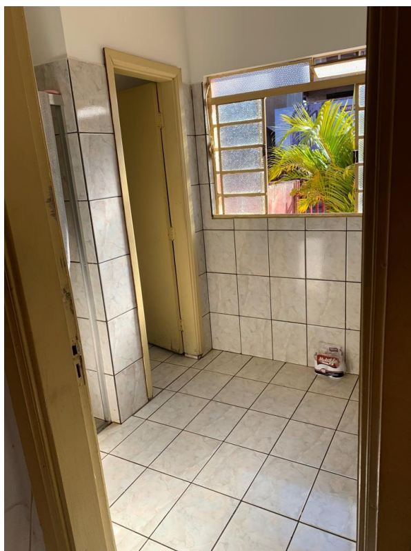
Imagem 66: Porta de acesso ao Banheiro (Dormitórios/Sala de descanso)
