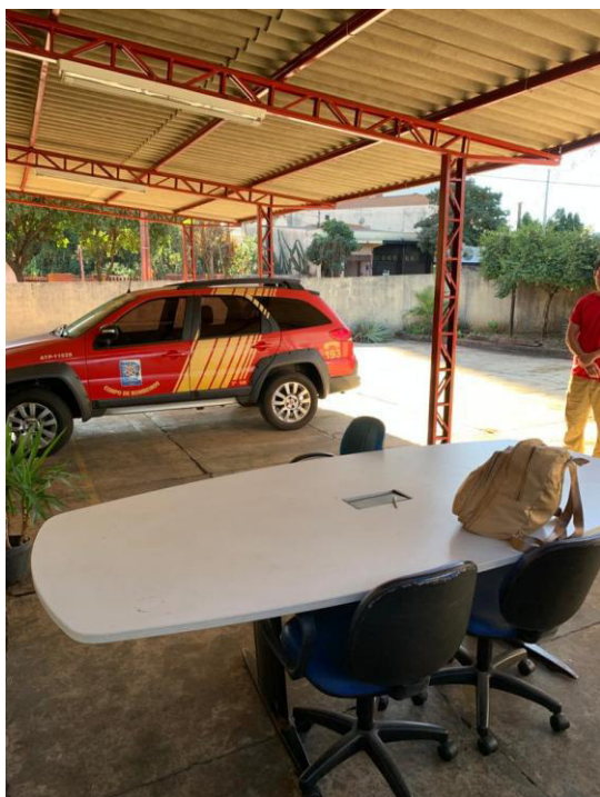
Imagem 93: Varanda coberta (pátio lateral direito)
