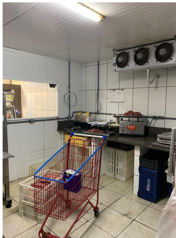
Imagem 78: Sala de corte/preparo de carnes
