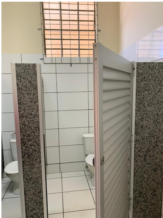
Imagem 25: Banheiro feminino (bacia sanitária 3)
