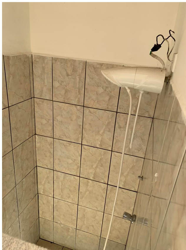
Imagem 70: Chuveiro (banheiro dormitórios/sala de descanso)
