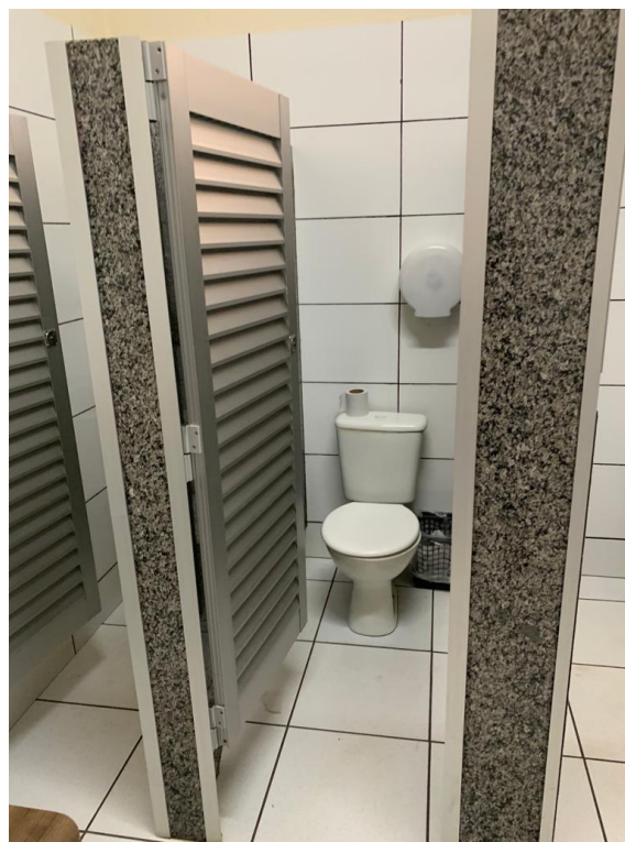
Imagem 26: Banheiro feminino (bacia sanitária 2)
