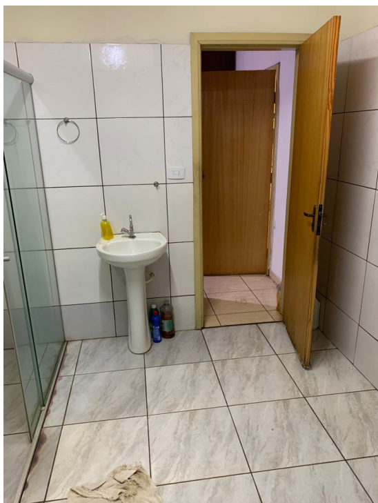
Imagem 39: Lavatório 1 (banheiro vestiário)
