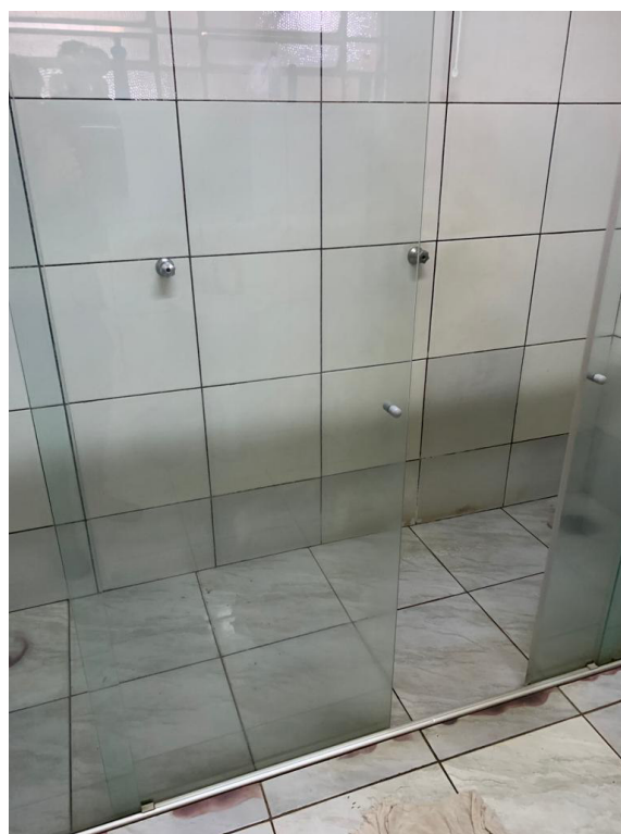
Imagem 44: Box (banheiro vestiário)
