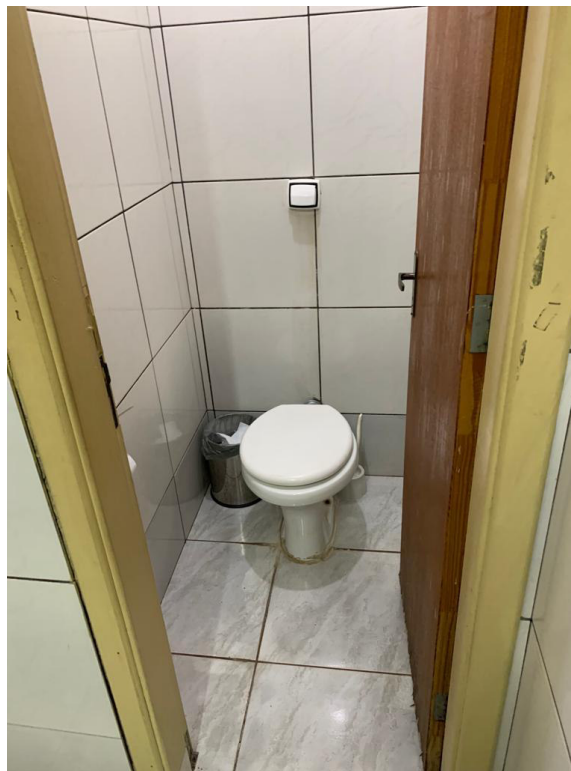
Imagem 42: Bacia sanitária 2 (banheiro vestiário)
