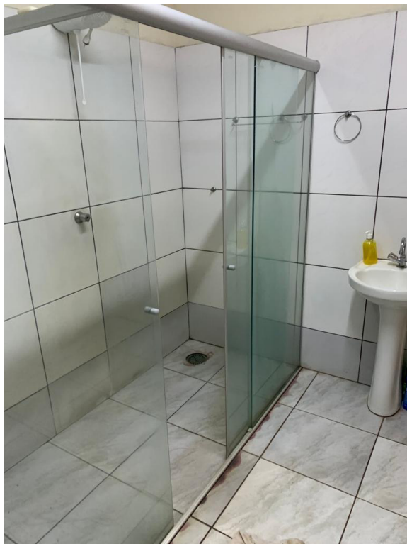
Imagem 43: Box (banheiro vestiário)
