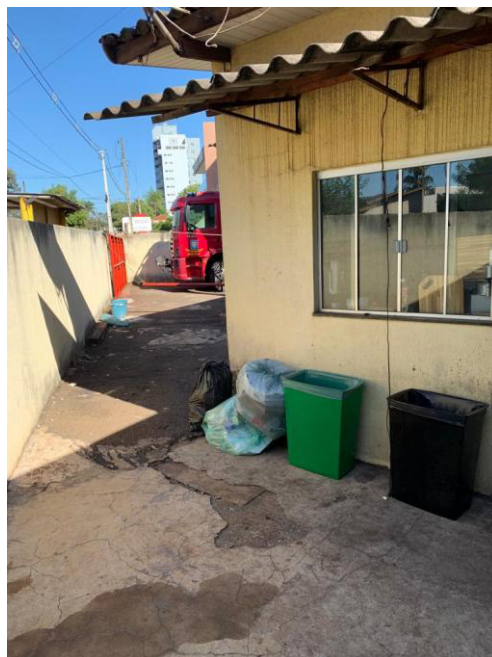
Imagem 86: Pátio lateral direito com vista para a divisa de fundos da edificação
