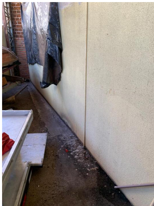
Imagem 82: Pátio dos fundos com vista para a parede de fundos do depósito
